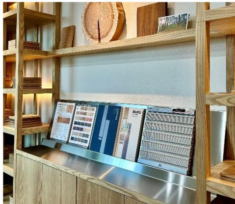
中央部分の棚は、外壁材のサンプルを展示・収納するスペースとなっており、物の出し入れが多くなるので、耐久性の強い、ステンレス板を仕上げ材に使用しました。
